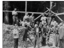
Viele Helfer beim Bau der Lemberghalle
