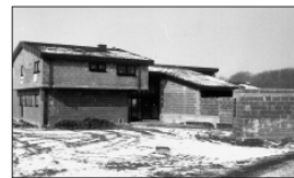
Das Vereinsheim entsteht
